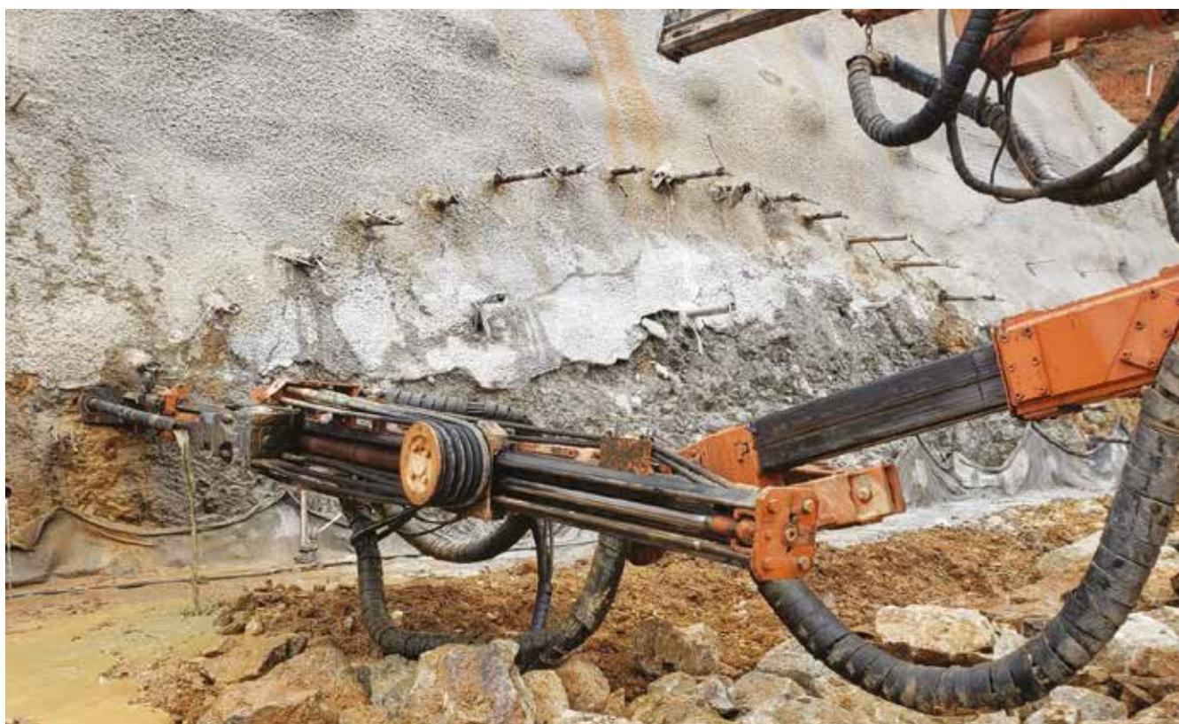
Enfilagem para túneis é um método de injeção de calda de cimento por meio de tubos em maciços. O procedimento é utilizado para aumentar a estabilidade dos solos, geralmente em áreas de emboque e escavações de túneis, pois transfere as cargas na direção longitudinal, diminuindo com isso as deformações induzidas pelas escavações. As enfilagens, portanto, são um sistema que atuam como pré-suporte para o avanço das escavações.
