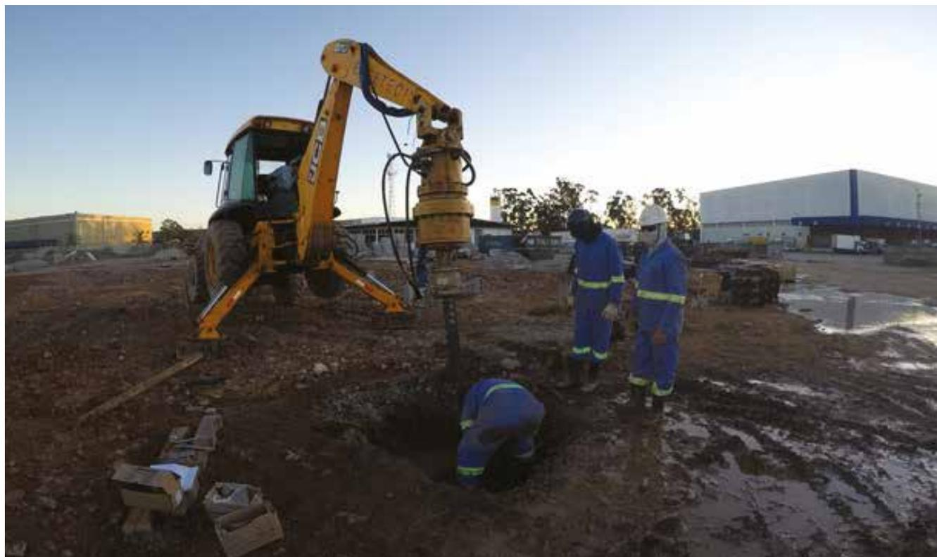
**Estacas Helicoidais são elementos de fundações profundas constituídas por uma haste metálica tubular na qual são soldadas múltiplas hélices e é instalada no solo através de torque.**
